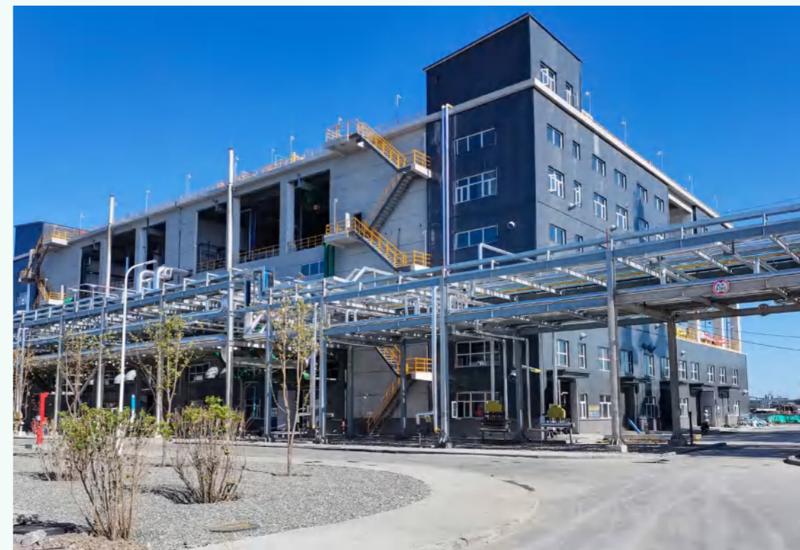
公司参建的东华天业年产 10 万吨 PBAT 工程项目
