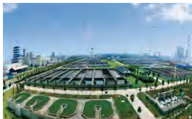
上海白龙港污水处理厂，日处理污水能力280万吨，亚洲最大的污水处理厂，荣获国家优质工程金质奖和中国市政金杯示范工程
