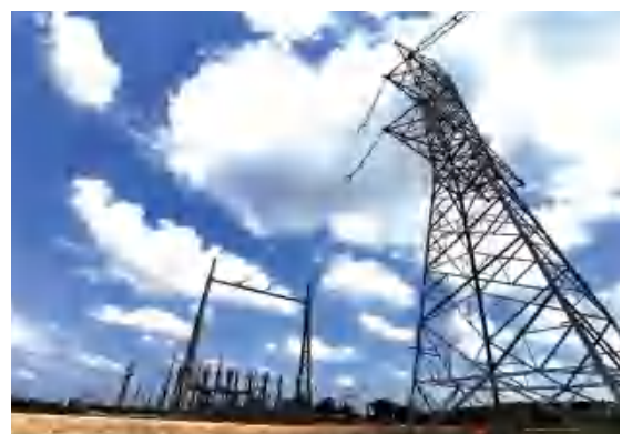
OMVG西非四国跨境输电线路工程
