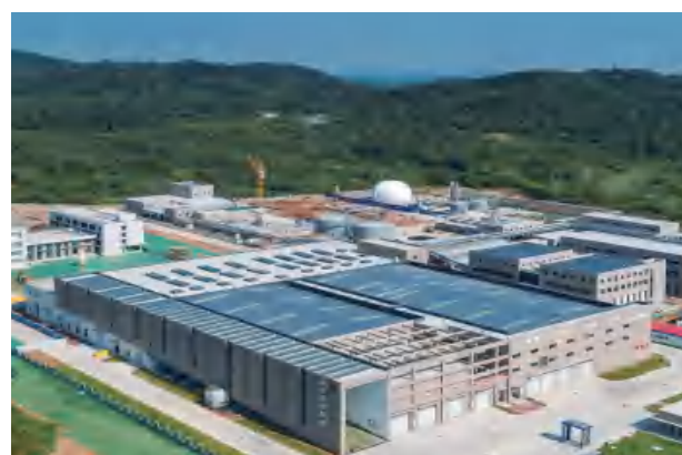
南京江北废弃物综合处置中心工程，国内第一个工艺系统齐全、技术先进、资源化程度高的餐厨垃圾处理项目
