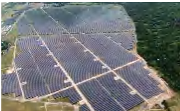
越南Saomai 二期106兆瓦光伏电站项目
