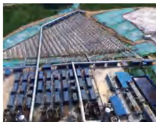
南京原煤制气厂地块土壤及地下水修复工程(全国单体量最大的燃气热脱附项目)
