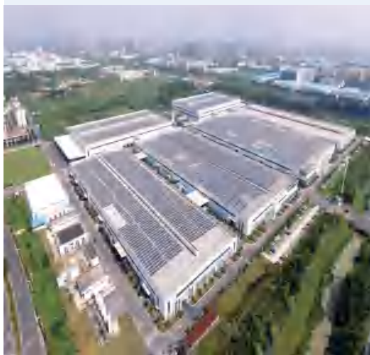
分布式光伏电站：安徽合肥 100MW 分布式电站群
