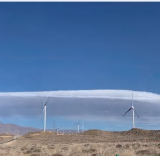
青海切吉 50MW 高原风电项目
