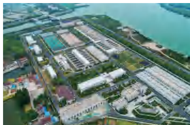
常州魏村水厂日供水处理规模70万吨，生活用水提高为“优质水”
