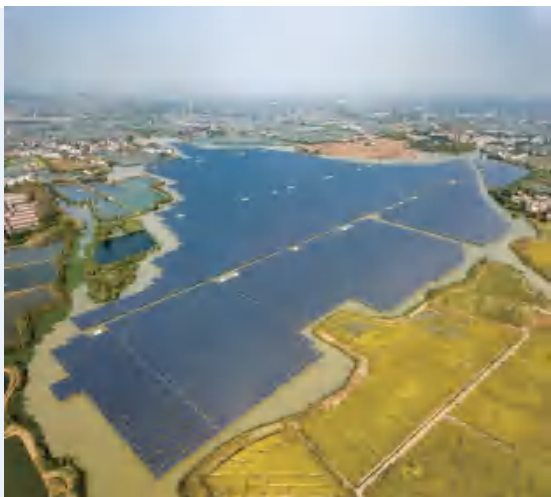
集中式光伏电站：浙江湖州 80MW 水面电站
