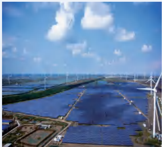
江苏东台 50MW 沿海滩涂风光互补电站
